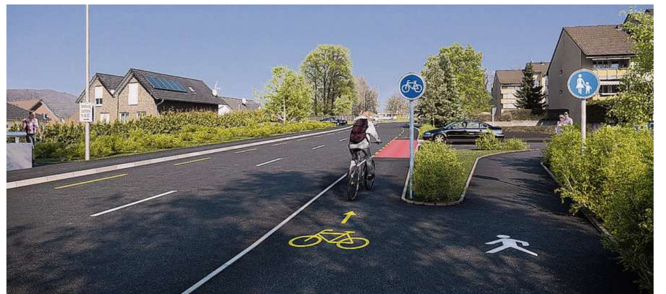
Mehr Raum, mehr Sicherheit. Fussgänger erhalten eigene, klar von der Strasse abgetrennte Wege. Visualisierung
